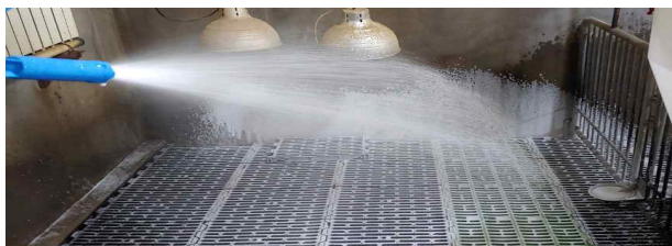
축사 세척 및 소독(벽면)
