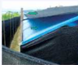
2중직 차광망 설치
