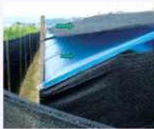
2중직 차광망 설치
