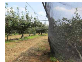
과수원 파풍망 설치
