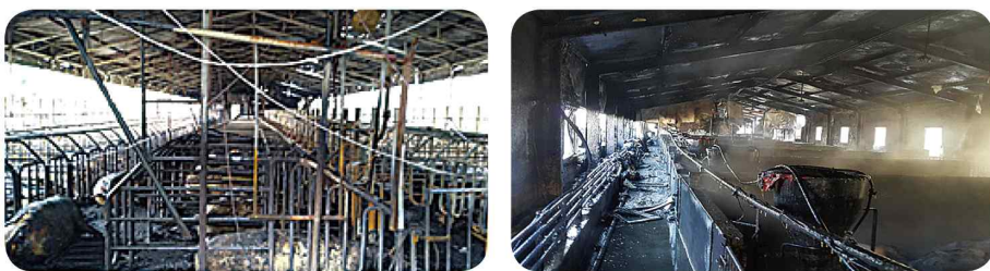
축사 전기화재 피해 사례
