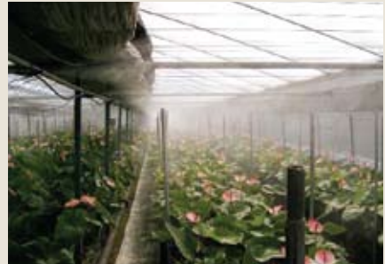
자동포그시스템을 이용한 온·습도 관리
