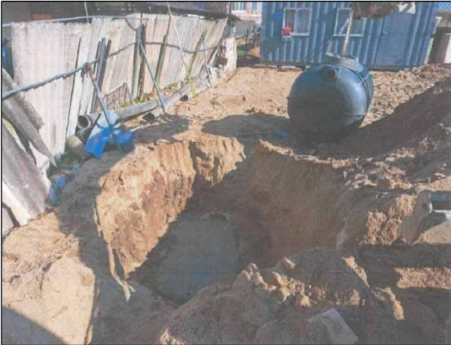
텃파기 및 콘크리트 타설
