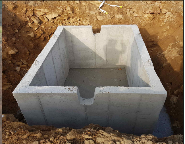
방호벽 시공(박스시공) ※해당되는 경우
