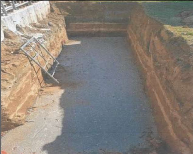
덧파기 및 바닥 콘크리트 타설
