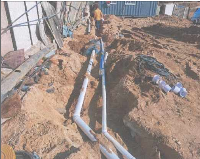
정화조 배관 시공
