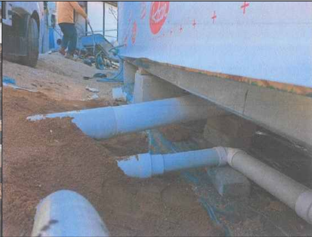
화장실 배관 시공
