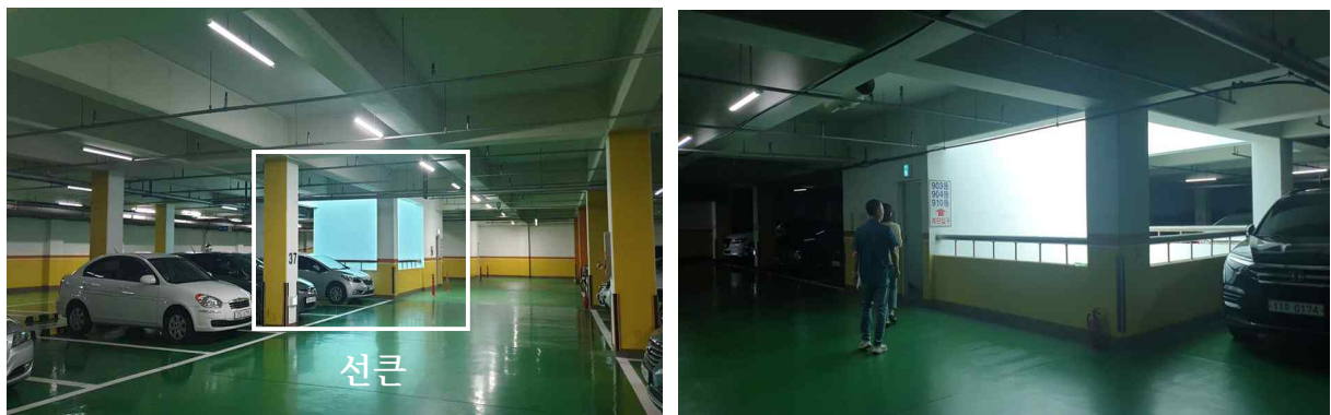
<그림 23> 선큰이 설치된 지하주차장
