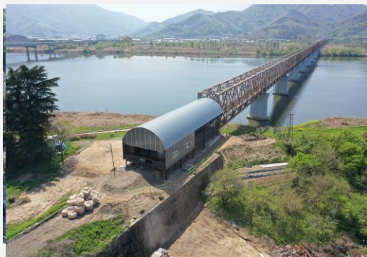
경상남도 김해시 철로자전거 회차장 신축공사
