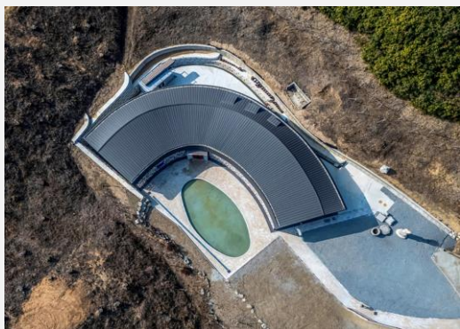
강원도 강릉시 인월사 담마센터 징크지붕시공
