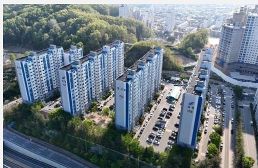
경상북도 영주 첼시빌아파트 옥상스틸방수공사
