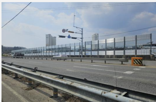
경상북도 문경시 경서로 방음벽 공사.
