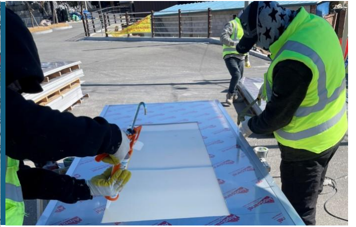
실링 및 리벳고정작업
