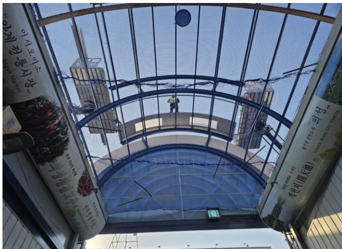
안전망 설치 후 커넥팅바 고정
