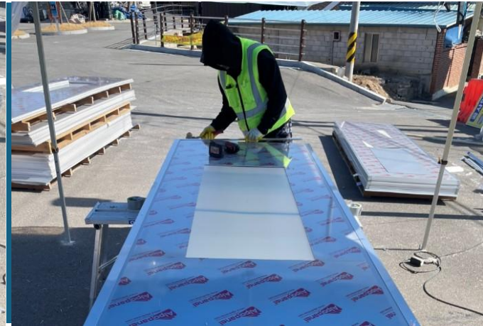
상,하 패널 AL바 조립
