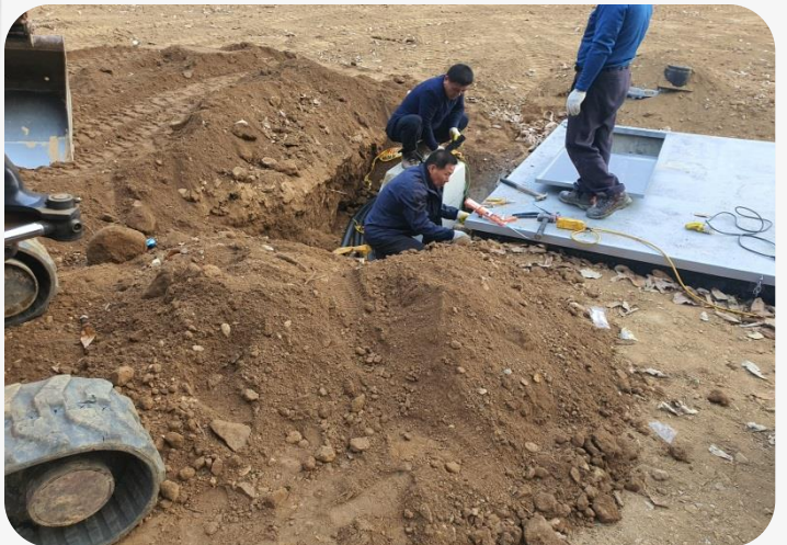
용상2정수장 상수도관로 공사현장(2020.06 ~ 2020.09)
