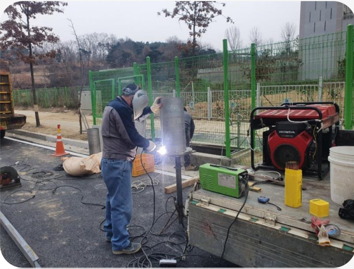
경북도청 오수중계펌프장 보완작업공사현장(2020.04 ~ 2020.04)
