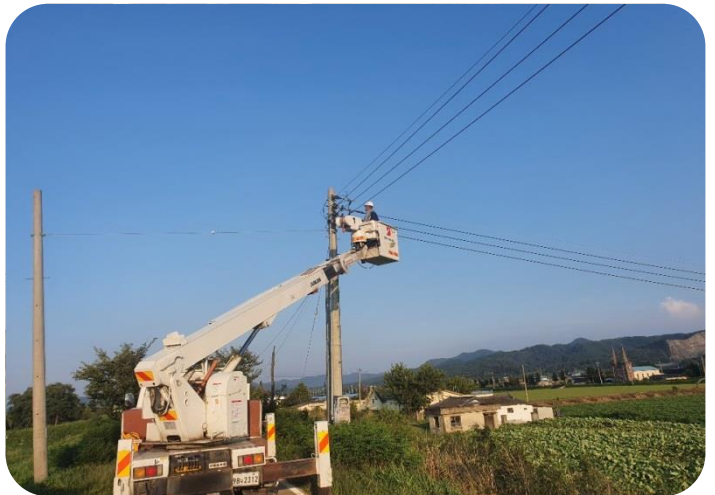
국가하천 가동보 보수공사 (2020.12 ~ 2020.12)
