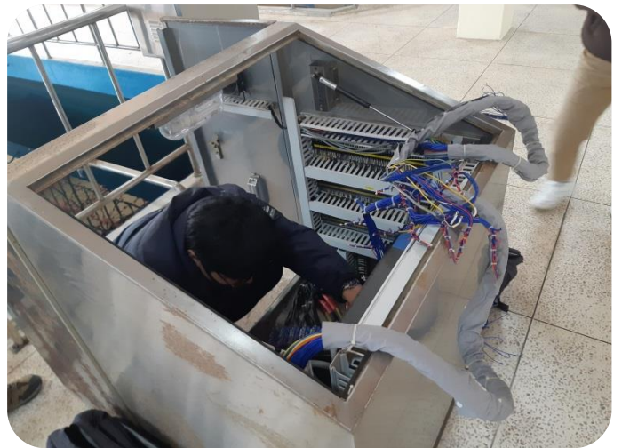
정수장 여과지 터치스크린 설치공사(2019.11 ~ 2019.12)
