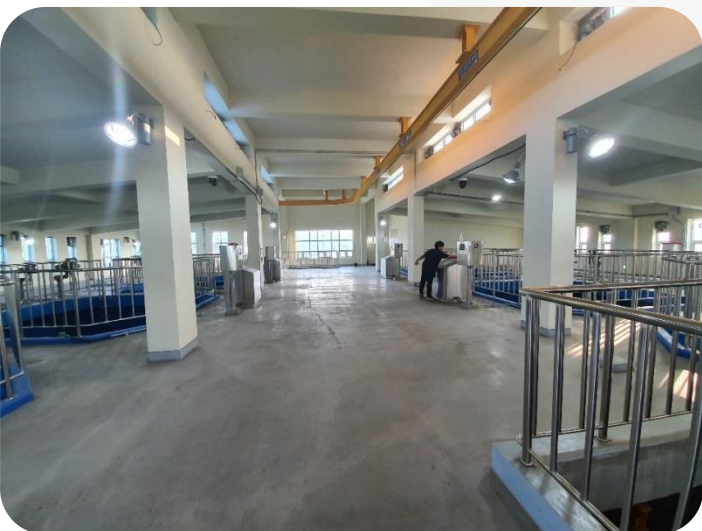
용상1정수장 여과지 조명 원격제어 설치작업(2020.08 ~ 2020.08)
