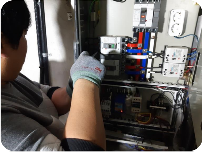
풍산현애가압장 외 39개소 전력감시장치 설치 공사(2019.11~ 2019.12)
